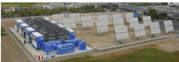
夜間電力や太陽光発電電力を貯蔵するレドックスフロー電池（容量1MW×5時間）と再エネ源としてのCPV（15基、最大発電量100kW）から構成され、外部の商用電力系統とも連系します。
