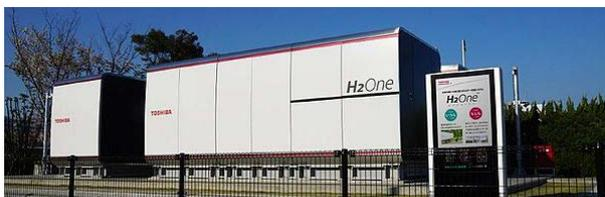
「H2One」は、太陽光発電設備、蓄電池、水素を製造する水電気分解装置、水素貯蔵タンク、燃料電池などを組み合
