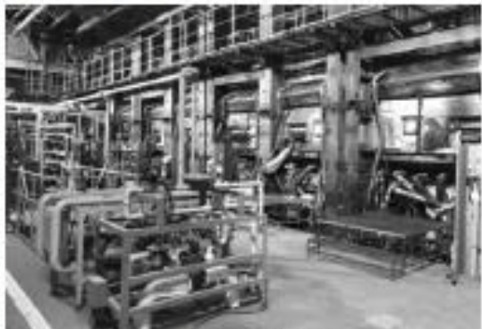
実証実験を行う溶解炉
